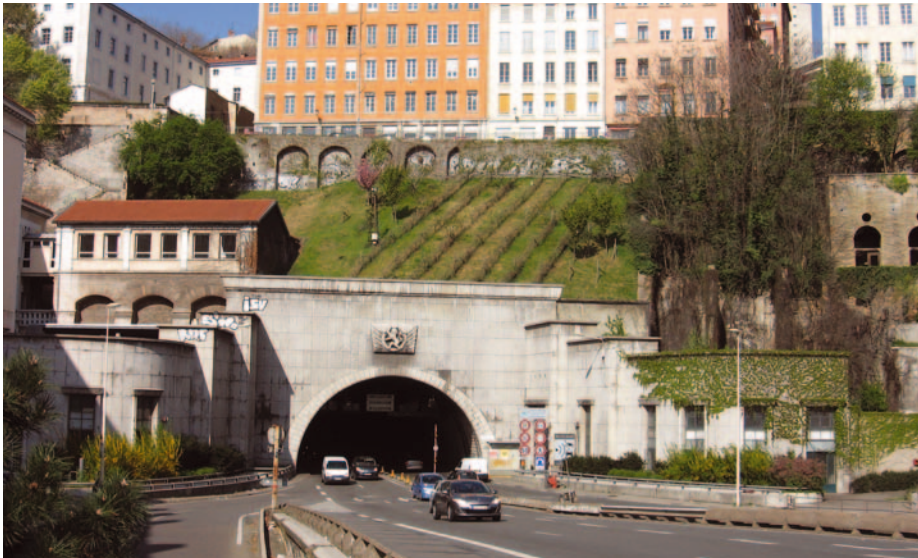
Figuur 5 Tunnel de la Croix Rousse Lyon - Oostelijk tunnelportaal
