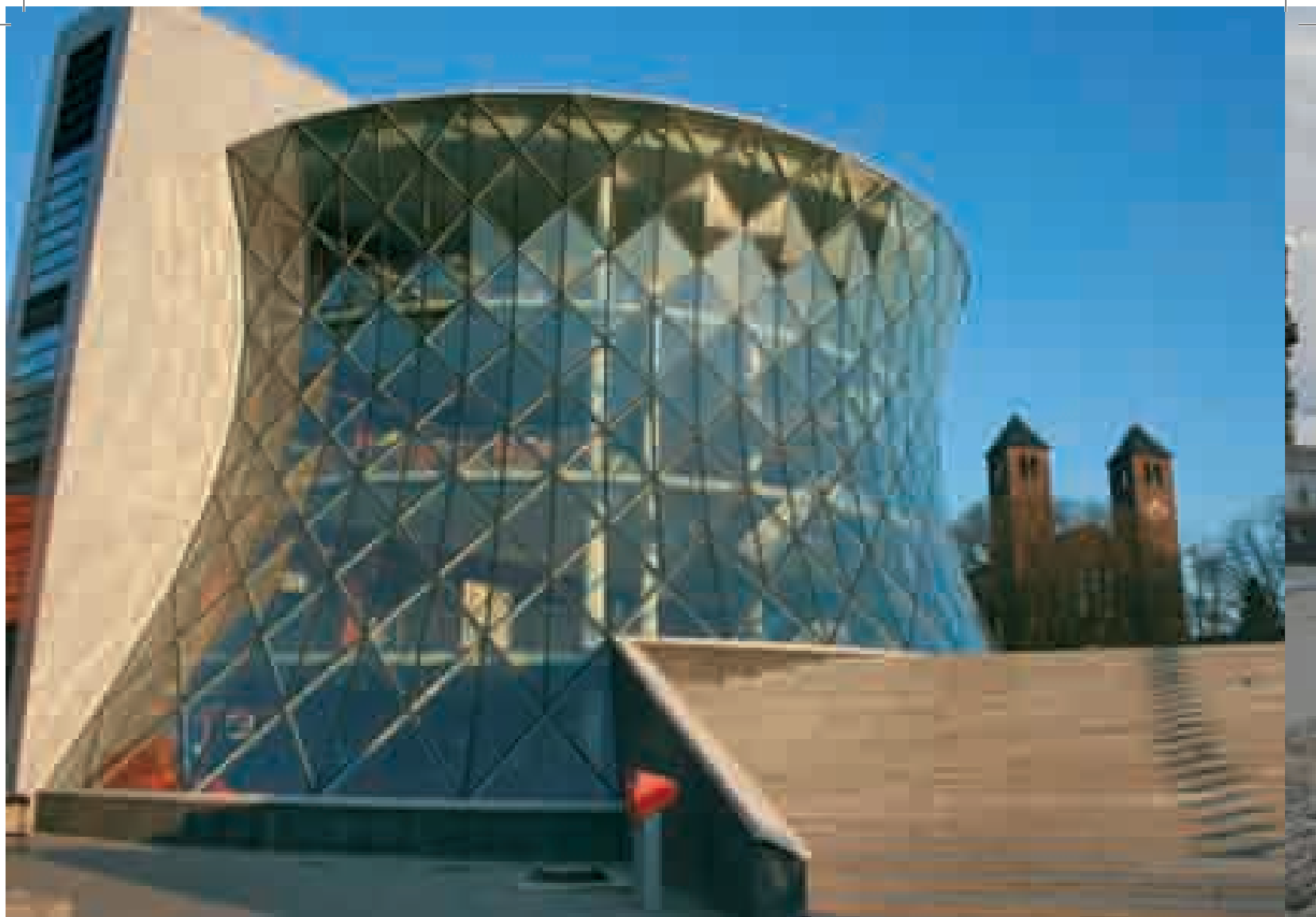
Kwaliteitsverhoging Parkstad Limburg/herstructurering Heerlerheide (nieuwbouwcomplex 'Gen Coel' in het stadsdeel Heerlerheide, gebaseerd op vorm oude mijnkoeltorens)
